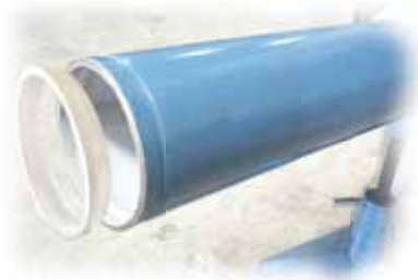
2.2 นำ Grooved line Gasket มาสวมที่ปลายท่อ เพื่อป้องกันไม่ให้น้ำที่ไหลผ่านสัมผัสหน้าตัดท่อ (กรณีติดตั้งท่อด้วย Coupling ควรใส่ Grooved line Gasket ที่ปลายทั้งสองด้าน)
