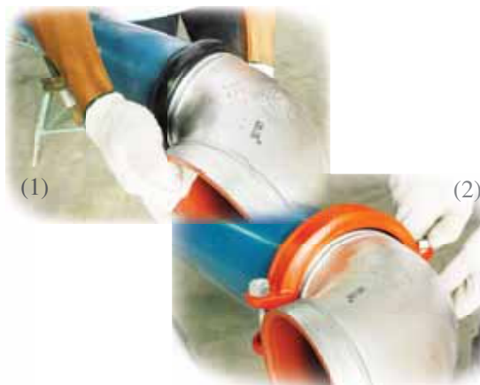
2.5 นำข้อต่อ Coupling มาประกอบพร้อมขันน็อตจนแน่น
