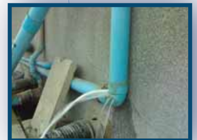
ท่อ PVC ไม่แข็งแรง กรอบแตก รั่วง่าย
