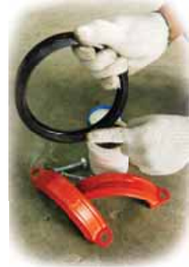
2.3 ทาน้ำยาหล่อลื่น Lubricant ที่ขอบยาง เพราะหน้าตัดท่ออาจมีคมของเหล็กทำให้ยางเกิดเป็นรอยแผลขนแมวเล็กๆ อายุการใช้งานจะเสื่อมลง การทา Lubricant จะช่วยยืดอายุการใช้งานของยางให้ยาวนานขึ้น
