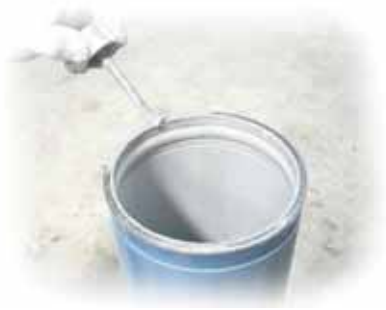
2.1 ทากาวเซอร์เมสซีล 55 ที่หน้าตัดท่อเพื่อป้องกันสนิมบริเวณหน้าตัดท่อ
