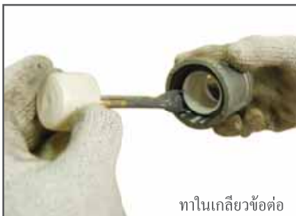
ทำให้ทั่วบริเวณเกลียวและในส่วนหน้าตัดท่อ
