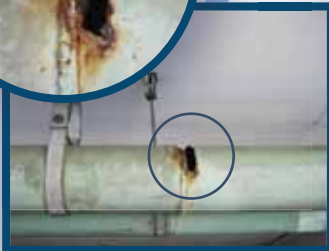
สนิมกัดกร่อนรอยเชื่อม ของท่อเหล็ก
