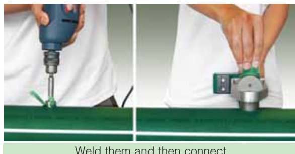
วิธีเจาะและเชื่อมข้อต่ออานม้า
