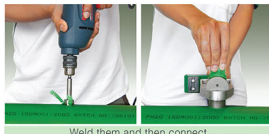
วิธีนี้จะและเชื่อมข้อต่ออานม้า
